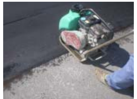
写真-3 端部のすり付け状況
