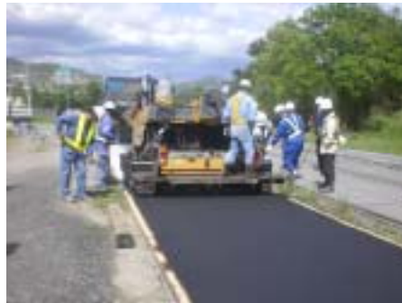
写真-2 施工状況
